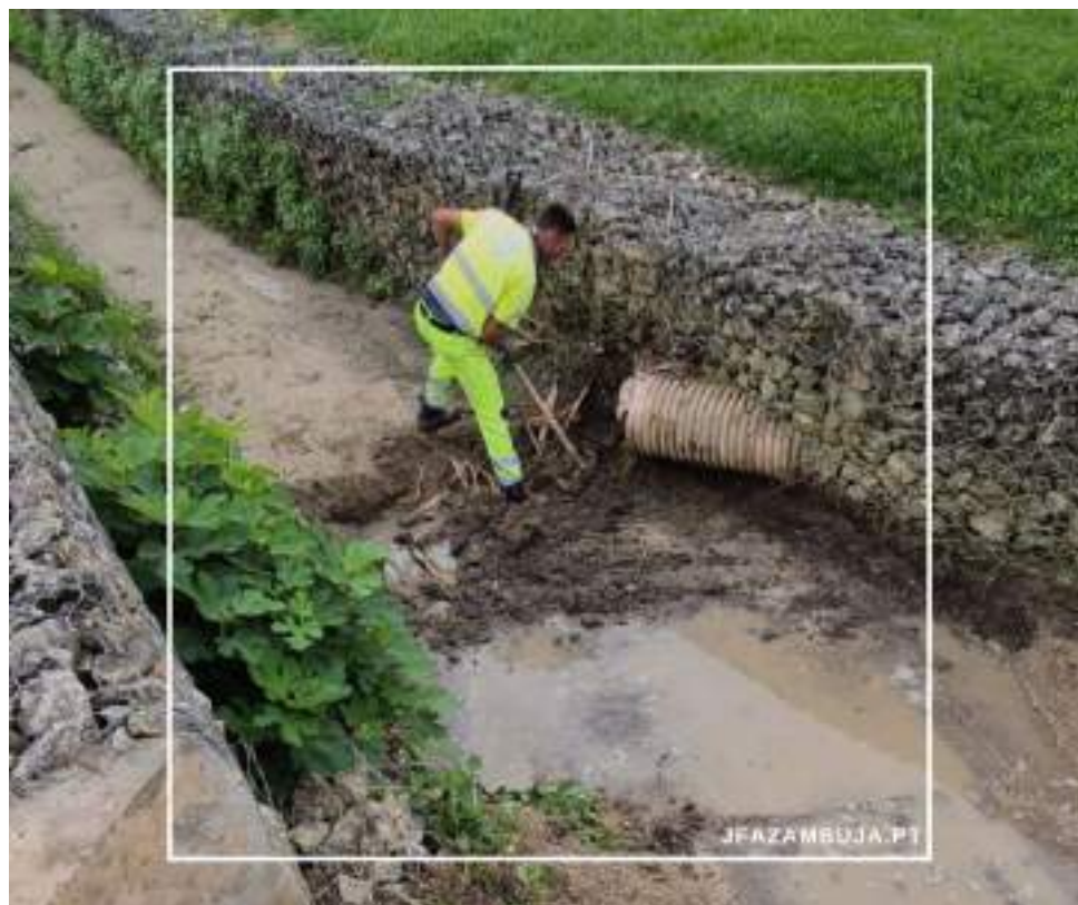
Figura 15 Apoio na limpeza e desobstrução de linhas de água
