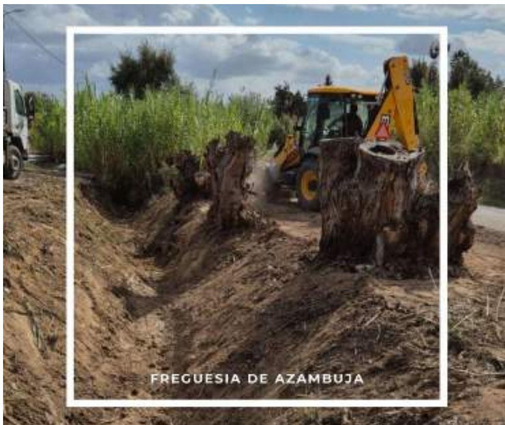
Figura 13 Apoio na limpeza e desobstrução de linhas de água
